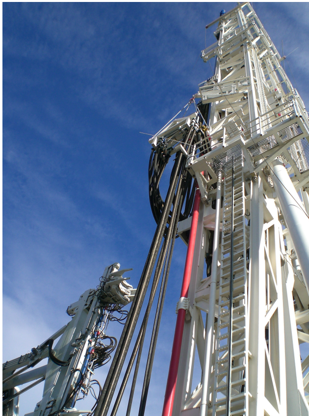
Starker Partner: Die Firma H. Angers & Söhne führt seit mehr als 140 Jahren Bohrungen durch
